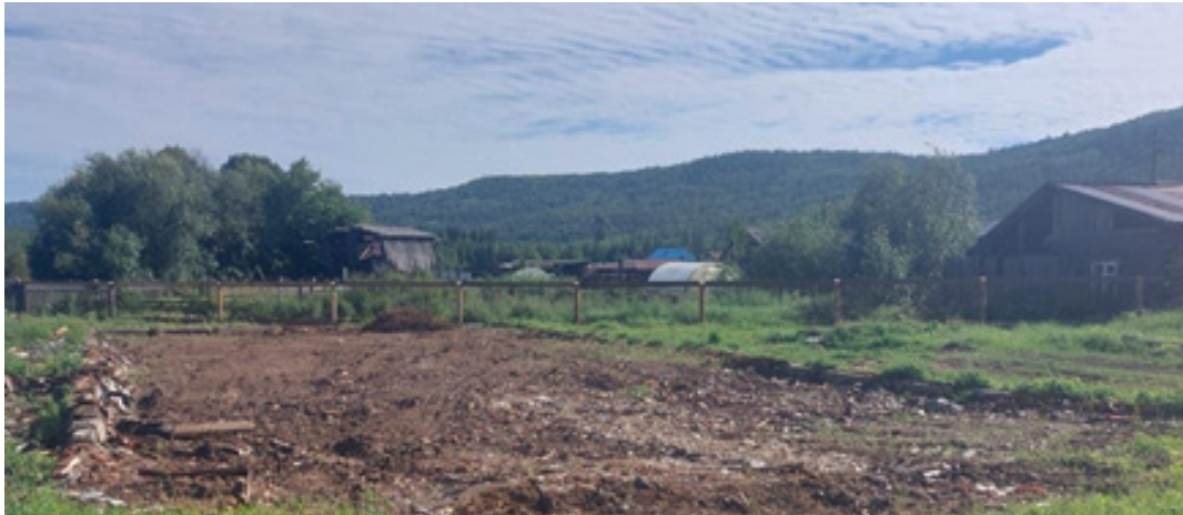
Рис 17. Территория МКДОУ ДС с. Подволошино после сноса аварийного корпуса.
